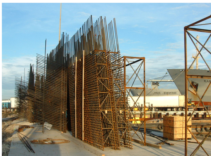
Figur 2.15 Stabilisering av najad korg med fackverk (system Arm-Tec)
