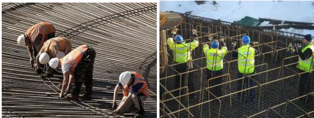
Figur 1.1 Exempel på armeringsarbete
