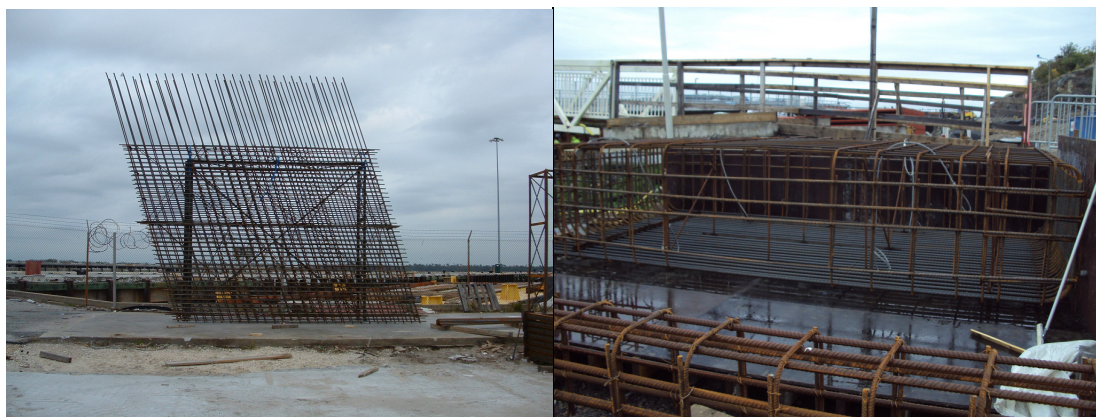
Figur 2.14 Stabilisering av najade nät och korgar m h a kompletterande diagonaler
