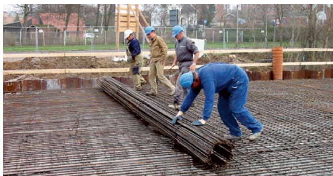
Figur 2.8 Utläggning av utrullningsbar armering (Arm-Tec system "Spinmaster")
