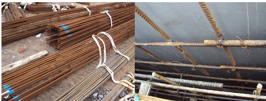
Figur 2.9 Bilder på dåligt exempel på rullarmering
